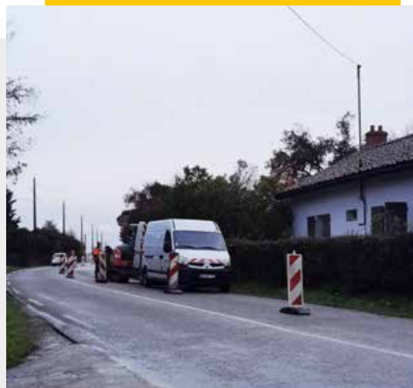
Route de Pont de Vaux
